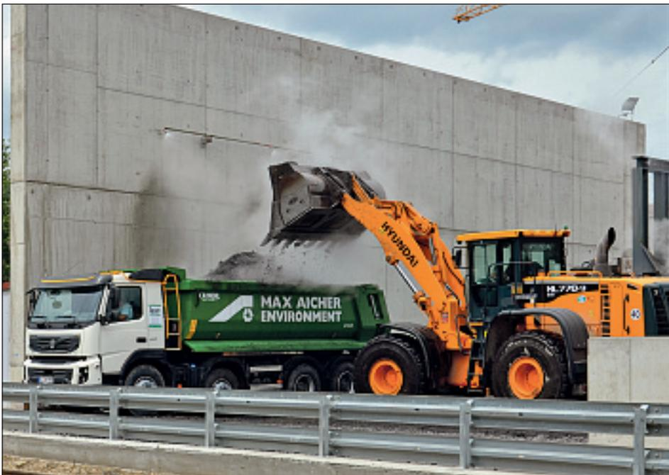
Ein Nebelvorhang aus feinst verdüstem Wasser verhindert Staubemissionen beim Verladevorgang zum Abtransport der Elektroofenschlacke vom Schlackenbeet zur Aufbereitungsanlage. Dort wird in einem aufwändigen Behandlungsprozess der güteüberwachte Ersatzbaustoff EloMinit® hergestellt, der für den Straßenbau besonders gut geeignet ist. ©LSW
