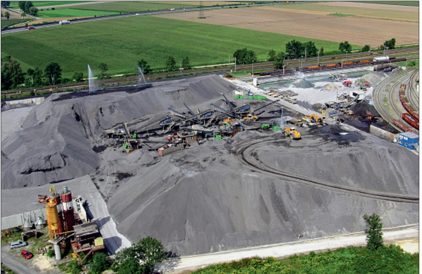
Die Aufbereitungsanlage von Max Aicher Umwelt, in der aus Elektroofenschlacke der güteüberwachte Ersatzbaustoff EloMinit® hergestellt wird.
