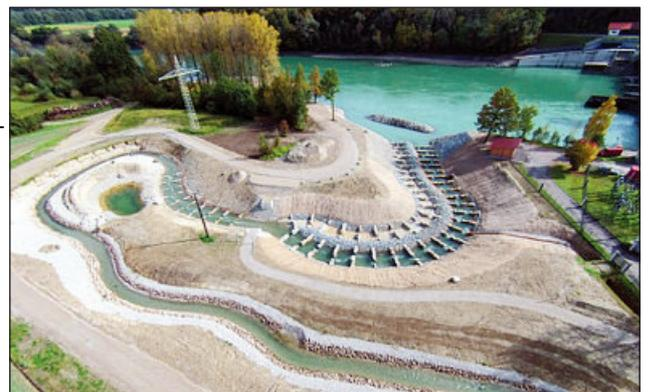
Neuer Lebensraum entstand bei der Fischwanderhilfe in Gars am Inn. In diesem naturähnlichen Bach fließen auf 480 Metern im Minimum 800 Liter pro Sekunde. Bild: VERBUND
