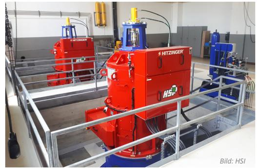
HSI ersetzt im Iller-Kanal-Kraftwerk Neu-Ulm der Stadtwerke Ulm die über 90 Jahre alten beiden Francis-turbinen durch zwei hochmoderne, vertikale, doppelt regulierte HSI-Kaplan-Schachtturbinen Typ TD4-141-R mit direktgekoppelten Synchrongeneratoren.
