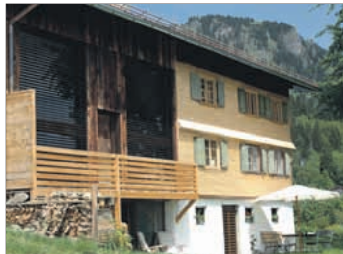
Der Hauptdenkmalpreis des Bezirks Schwaben wurde für die Sanierung eines Bauernhauses bei Bad Hindelang vergeben. Bild: Bezirk Schwaben
