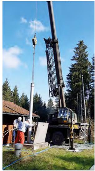
Bild 1: Pumpenwechsel (Beispielbild). □
