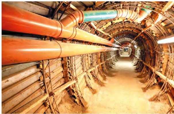
Im Stollenquerschnitt sind neben der Stromversorgung für die Beleuchtung und anderer technischer Geräte noch die Bewetterung sowie die provisorische Abwasserleitung untergebracht.
