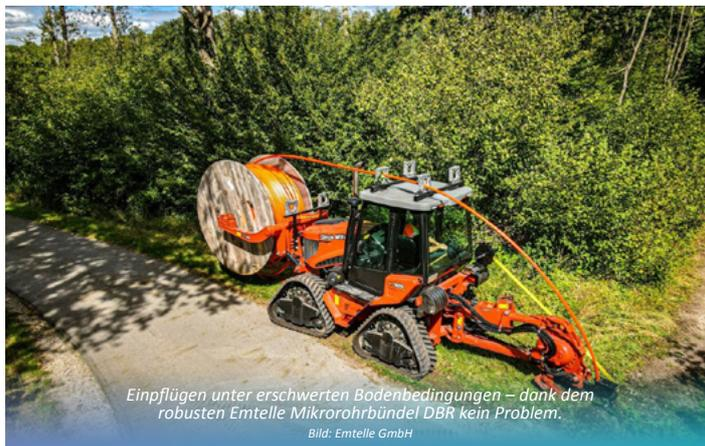
Einpflügen unter erschwerten Bodenbedingungen – dank dem robusten Emtelle Mikrorohrbündel DBR kein Problem.
