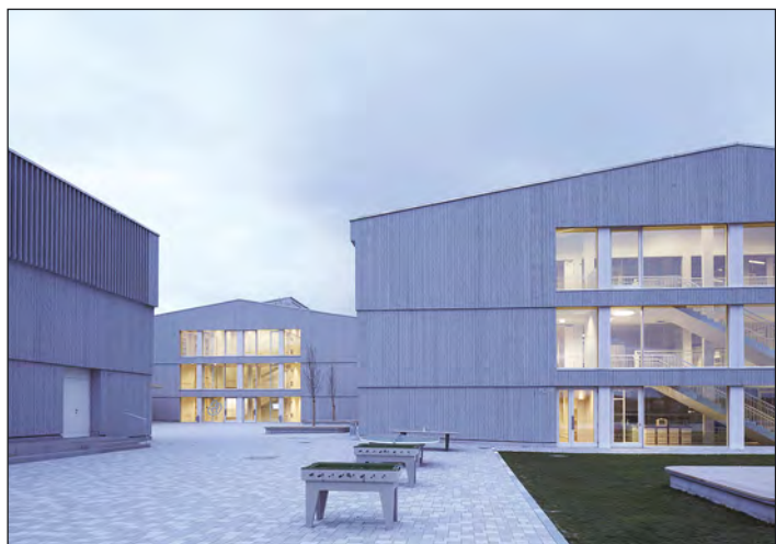
Dank Modulbauweise konnte die kreuzförmige Anlage kostengünstig und in nur zweijähriger Bauzeit fertiggestellt werden. □
