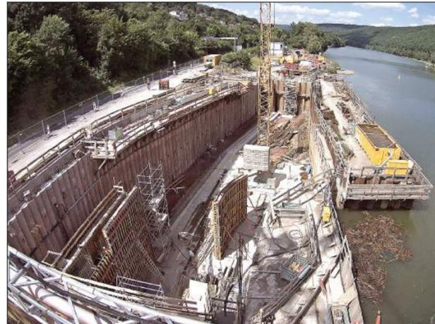
Der Blick in die Baustelle im Oberwasserbereich (Turbineneinlauf) ist aus Richtung Rothenfels flussaufwärts Richtung Lohr. Der Kran, von dem aus die Unterwasserbereichs-Aufnahme gemacht wurde, steht aktuell mitten in der Oberwasser-Baugrube (Bildmitte). Foto: Rhein-Main-Donau AG
