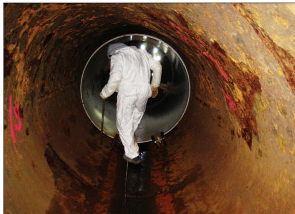
Damit das Altrrohr das neue GFK-Rohr aufnehmen kann, müssen die Verformungen des Altrrohres mit Hilfe eines Hydraulikstempels rückgängig gemacht werden.
