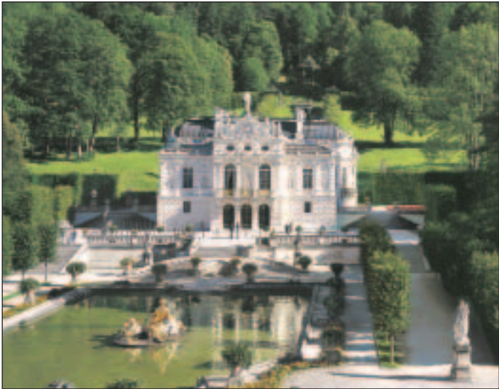
Kuchler-Service führte unter anderem Kanalbauarbeiten am Schloss Linderhof durch. Bild: ©Bayerische Schlösserverwaltung
