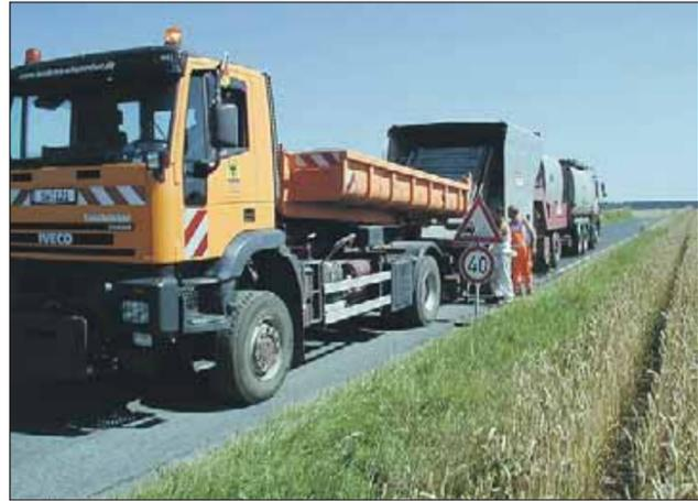
Im Landkreis Schweinfurt werden die Kreisstraßen saniert. Dabei kommt flächendeckend eine mit Rapsöl versetzte Bitumenemulsion als Bindemittel zum Einsatz. Durch den nachwachsenden Rohstoff wird nicht nur die Umwelt geschont, sondern auch die Gebrauchseigenschaften werden verbessert. □
