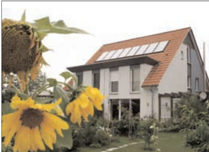
Ein Passivhaus in einer Siedlung in Nürnberg-Wetzendorf. Der aufgebaute Sonnenkollektor versorgt vier nebeneinander stehende Doppelhaushälften zur Heizungsunterstützung. h.w.
