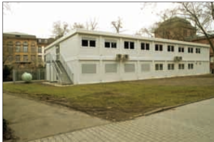
Der von der Graeff Container- und Hallenbau GmbH, Mannheim, gebaute provisorische Schulkomplex umfasst Klassen- und Sozialräume für etwa 250 Schüler. □
