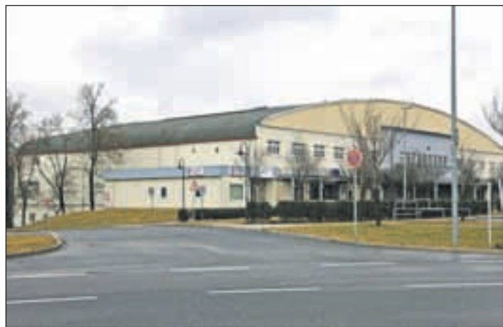
Die Flugzeughalle aus den 30er Jahren diente der Amerikanischen Gemeinde auf dem Leighton-Gelände u. a. als Theater. Eine Aufwertung des Geländes wäre schon aus optischen Gründen ein Gewinn. Foto: wkn
