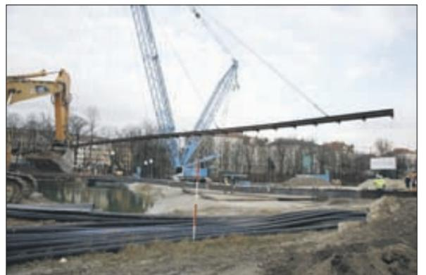
Schwappende Pipeline (unten) und Montagehilfe (Stahlträger oben).
