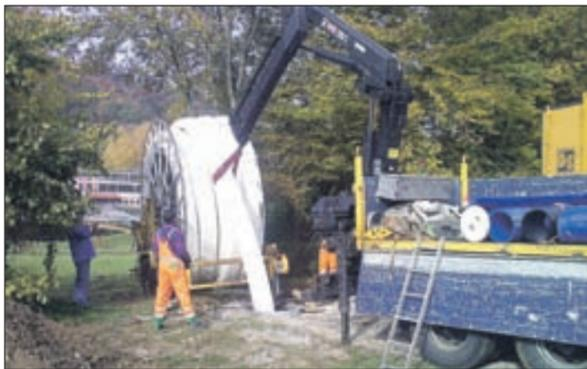
Compact Pipe wird auf einer Rolle zur Einbaustelle geliefert. Die Qualität der mit diesem Verfahren sanierten Kanäle entspricht der Qualität von neu verlegten PE-Standardrohren. Foto: Diringer&Scheidel Rohrsanierung
