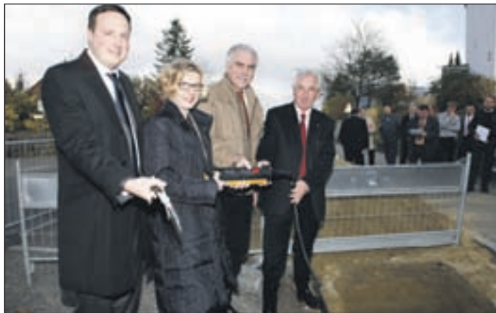
Beginn der Bauarbeiten: Markus Haas, Managing Director Telefónica O2 Germany, LEW TelNet-Geschäftsführerin Erna-Maria Trixl, Diedorfs Bürgermeister Otto Völk sowie der stellvertretende Landrat des Landkreises Augsburg, MdL Max Strehle (v. l.), starten per Knopfdruck den Bau des neuen Glasfasernetzes. Bild: Bleier / LEW
