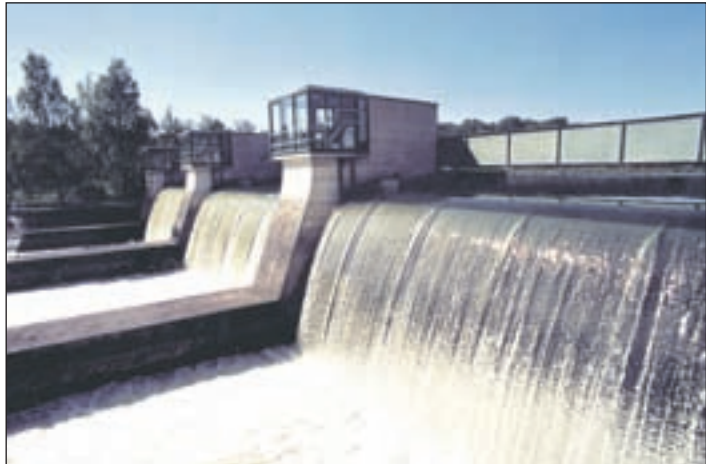
Das Wasserkraftwerk Günzburg.
