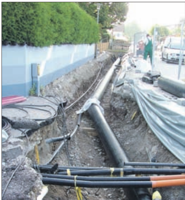
Bauarbeiten auf Hochtouren: Die durch Marktoberdorf verlaufenden Leitungen sollen die Abnehmer ab Oktober mit Fernwärme versorgen. □
