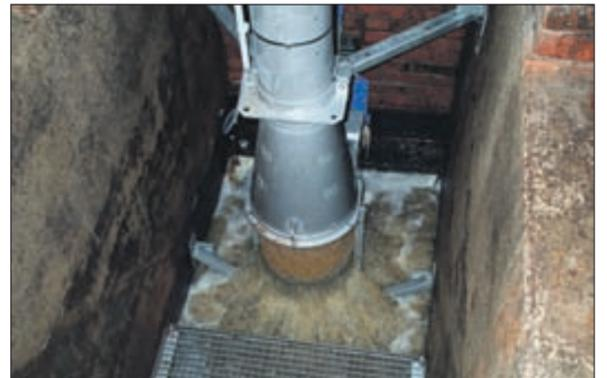
Die Siebanlage hält Störstoffe über 3 mm Durchmesser aus dem im Folgenden zur Energiegewinnung genutzten Abwasserstrom zurück. Bild: GFM Beratende Ingenieure GmbH
