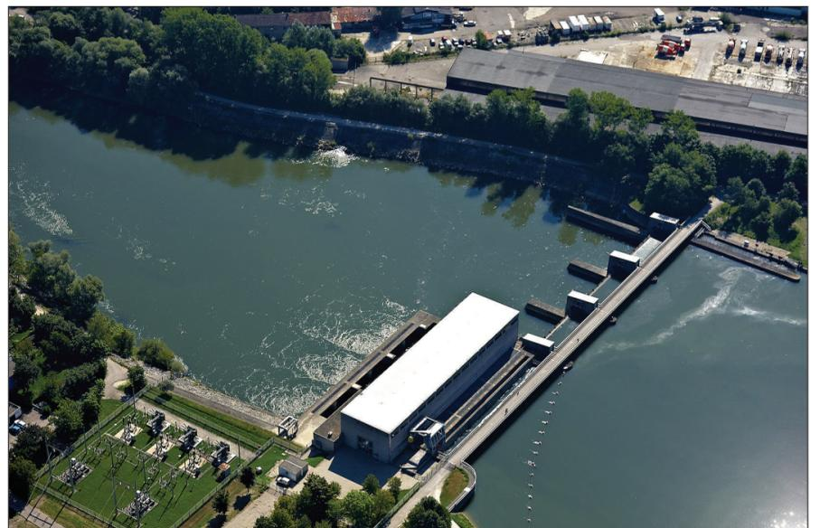
Donaukraftwerk Ingolstadt zur Bereitstellung von Bahnstrom (16 2/3 Hertz). Der Fischpass wird unterhalb der linken unteren Bildecke vorbeigeführt. Bild: Rhein-Main-Donau AG
