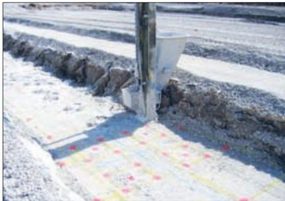
Bodenstabilisierung nach dem CSV-Verfahren: Mit 320 Säulen wurde ein sicherer Baugrund hergestellt.
