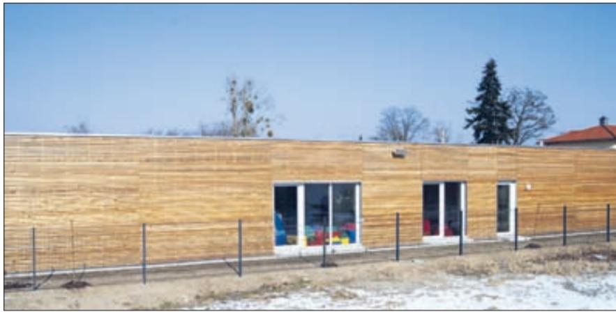
Die markante Fachwerkfassade aus Lärchenholz ist sichtbarer Bestandteil einer aufwändigen Isolierung des Gebäudes.
