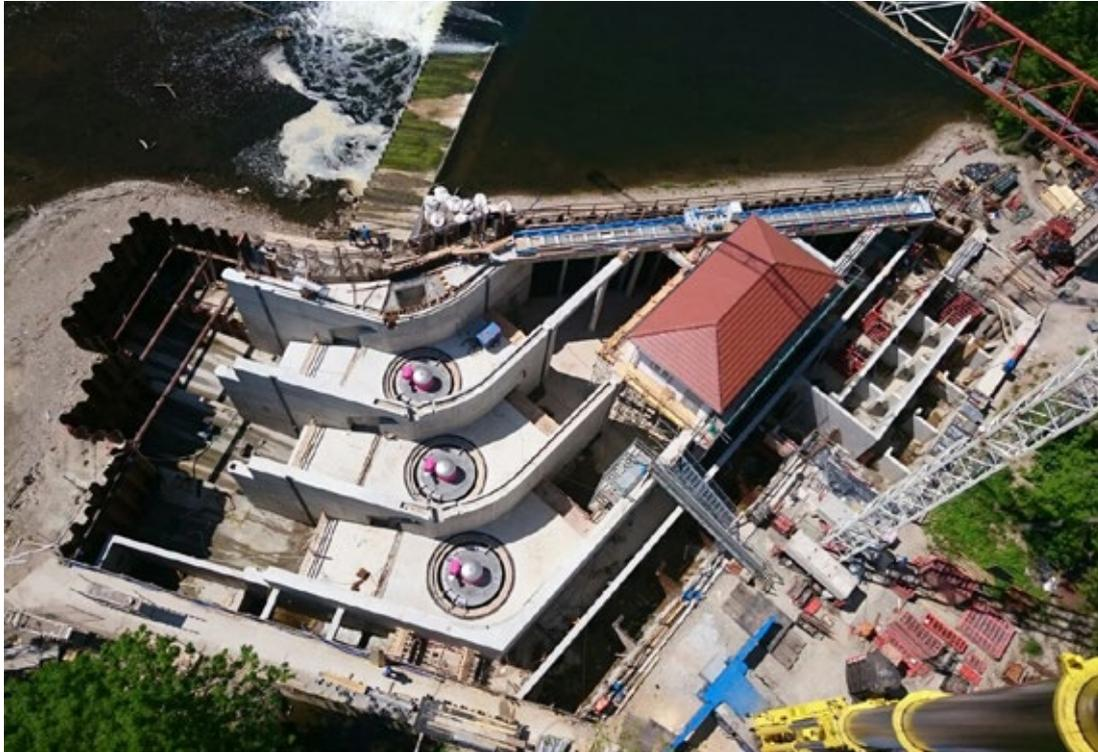
Ein aktuelles Finanzierungsprojekt der DKB in der finalen Umsetzungsphase: Die Wasserkraftanlage in Öblitz (Saale) mit einer Nennleistung von rund 900 kW. Die drei vertikalen Kaplanturbinen werden ab Herbst 2017 jährlich rund 4,3 Mio. kWh Strom ins Netz einspeisen.
