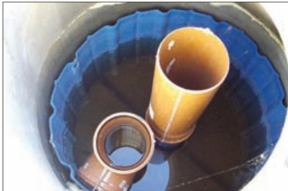
**Nach der Behandlung mit dem 3P Hydrosystem 1000 heavy traffic wird das Niederschlagswasser der stark frequentierten Verkehrsflächen rund um den Raiffeisenmarkt Merdingen nahezu in Trinkwasserqualität der Versickerung zugeführt.**
