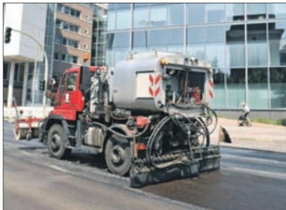
Ein Mercedes-Benz Unimog U 400 sprüht die Bitumenemulsion zum Einbau der nächsten Asphaltsschicht aus. □
