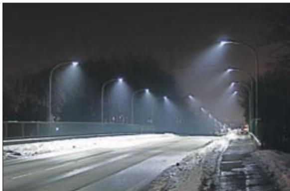
Weniger Leuchten, besseres Licht: Hier beleuchten 50 Archilede-Leuchten mit je 39 LEDs (57 W) die Straße. Sie wurden dank des Universalreduzierstücks für Mastaufsatz zur Vermeidung kostspieliger Erdarbeiten direkt auf die bestehenden Peitschenmasten montiert. Einsparung/Jahr: 5.000 kWh Energieverbrauch, 3,06 Tonnen CO<sub>2</sub>, 750 Euro Stromkosten. □
