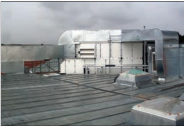
Am höchsten Punkt der Klinik: Zentrale Lüftungsanlage mit hocheffizienter Wärmerückgewinnung für Heiz- und Kühlfunktionen über den Dächern der Stadt.
