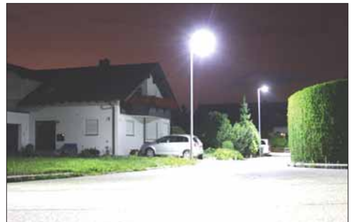
Intelligent geregelte LED Straßenleuchten von WiRE Umwelttechnik senken den Energieverbrauch und damit die Energiekosten. □
