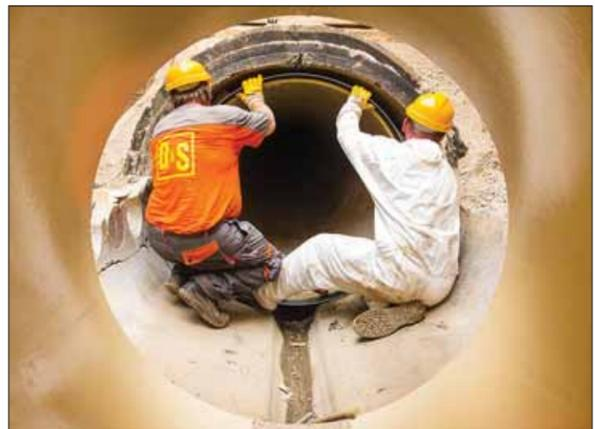
Die GFK-Rohre werden in die Haltung eingezogen und oben fixiert. Durch Längsrisse im Rohrscheitel war nicht nur die Statik infrage gestellt, sondern auch die Dichtheit der in einem Wasserschutzgebiet liegenden Mischwasserleitung. Foto: H. Jost
