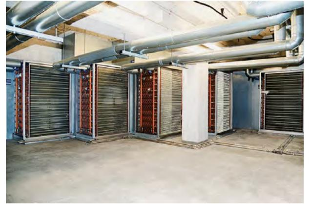
Die GSWT®-Technologie freistehend in großen Lüftungskanälen. Bild: SEW GmbH
