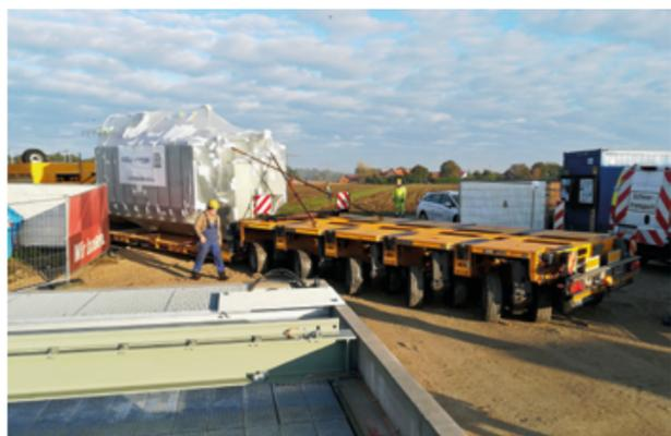
Präzisionsarbeit mit 60 Tonnen schwerer Ladung: Der erste von zwei neuen Transformatoren erreicht das neue Umspannwerk Olching. Bild: Thomas Riederer / Bayernwerk
