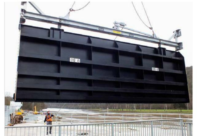
Die ausgebauten Dammtafeln bleiben bis zur dauerhaften Stromproduktionsfreigabe vor Ort beim Kraftwerk. Im späteren Regelbetrieb werden sie in einem benachbarten Mainkraftwerk der Rhein-Main-Donau AG gelagert. Bild: Jan Kiver, Rhein-Main-Donau AG
