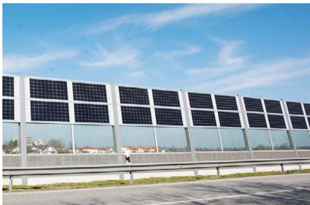
Das Konzept für die 234 Meter lange und 5 Meter hohe PV-Lärmschutzwand ist beispielhaft. Bild: Medienzentrums Altötting
