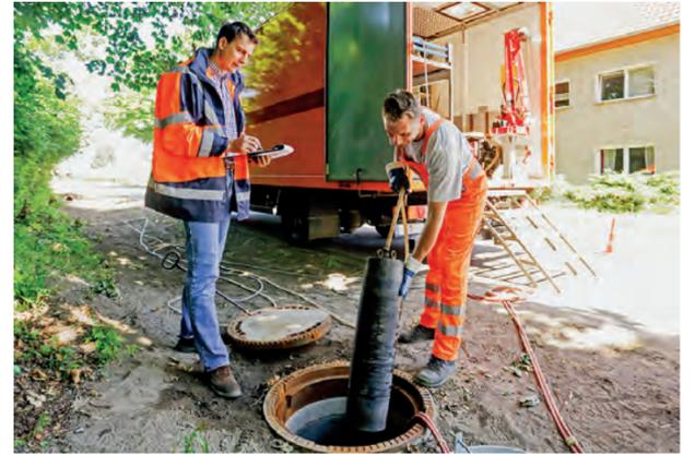
Im Rahmen der Baustellen- und Firmenbesuche bewerten die Prüfingenieure der Gütegemeinschaft Kanalbau die unterschiedlichen Arbeits- und Verfahrensweisen der Gütezeicheninhaber bei der Dichtheitsprüfung von Einzelrohrverbindungen sowie deren Dokumentation.
