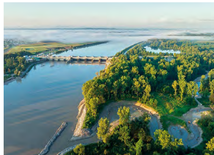
Die Fischwanderhilfe Braunau-Simbach wurde 2024 eröffnet.
