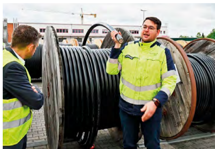
Zentrallagerleiter Georg Wallaschek erläuterte die Beschaffenheit und Technik der Kabel. Bild: Markus Bauer
