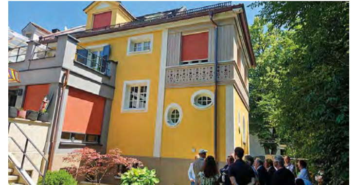
Auszeichnung als „Gestalter im Team Energiewende Bayern“ für eine sanierte Doppelhaushälfte aus dem Jahr 1921. Bild: Josef Hochhuber
