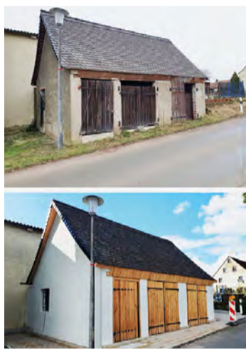
Vorher-Nachher des Gerätehaus der Freiwilligen Feuerwehr Obermichelbach. Bild: FFW Obermichelbach
