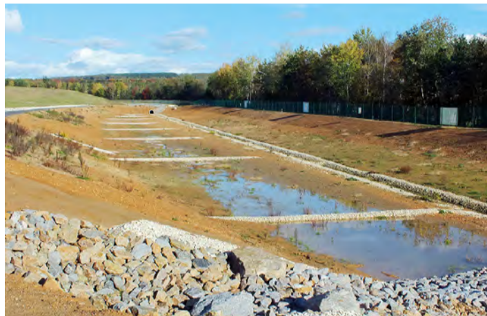
Blick auf das so weit wie möglich naturgerecht gestaltete zweite Hochwasserrückhaltebecken für den neuen Hochwasserschutzablauf der Gemeinde Wackersdorf im rekultivierten Westfeldgelände von Uniper.
