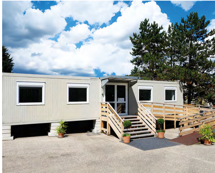
Die mobile Zahnarztpraxis aus ELA Containern wurde für den Hochwasserschutz auf Betonsockeln platziert. Bild: ELA Container
