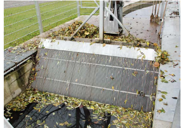
Die Rechen schützen die Turbine und fangen Plastikmüll ab. Bild: LVBW/Otto Mitterfelner
