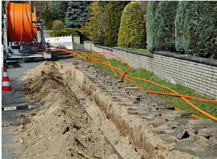
Glasfaserausbau neu gedacht.
