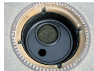
Aktivkohlefilter AFIP370, eingebaut mit Korb und Füllung Filtercassette der Biofilterpatrone FIP560 wird eingelegt (rechts oben) Wasserstopp WS103 mit neuem Sandfang (rechts unten)
