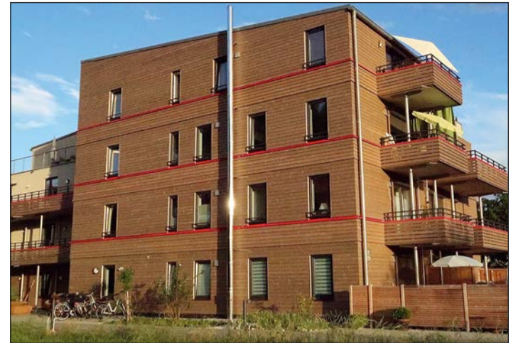
Die „Häuser für Demenz-WGs und Familien“ in Weilheim von SCHANKULA Architekten wurden in Holzständerbauweise errichtet und sind ein Beispiel dafür, dass Holz ein idealer Baustoff für kommunales Bauen ist. Bild: Peer Prechtl
