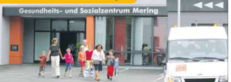
Gesundheits- und Sozialzentrum (GSZ) in Mering - für Wärme und Strom sorgt ein Erdgas-BHKW
