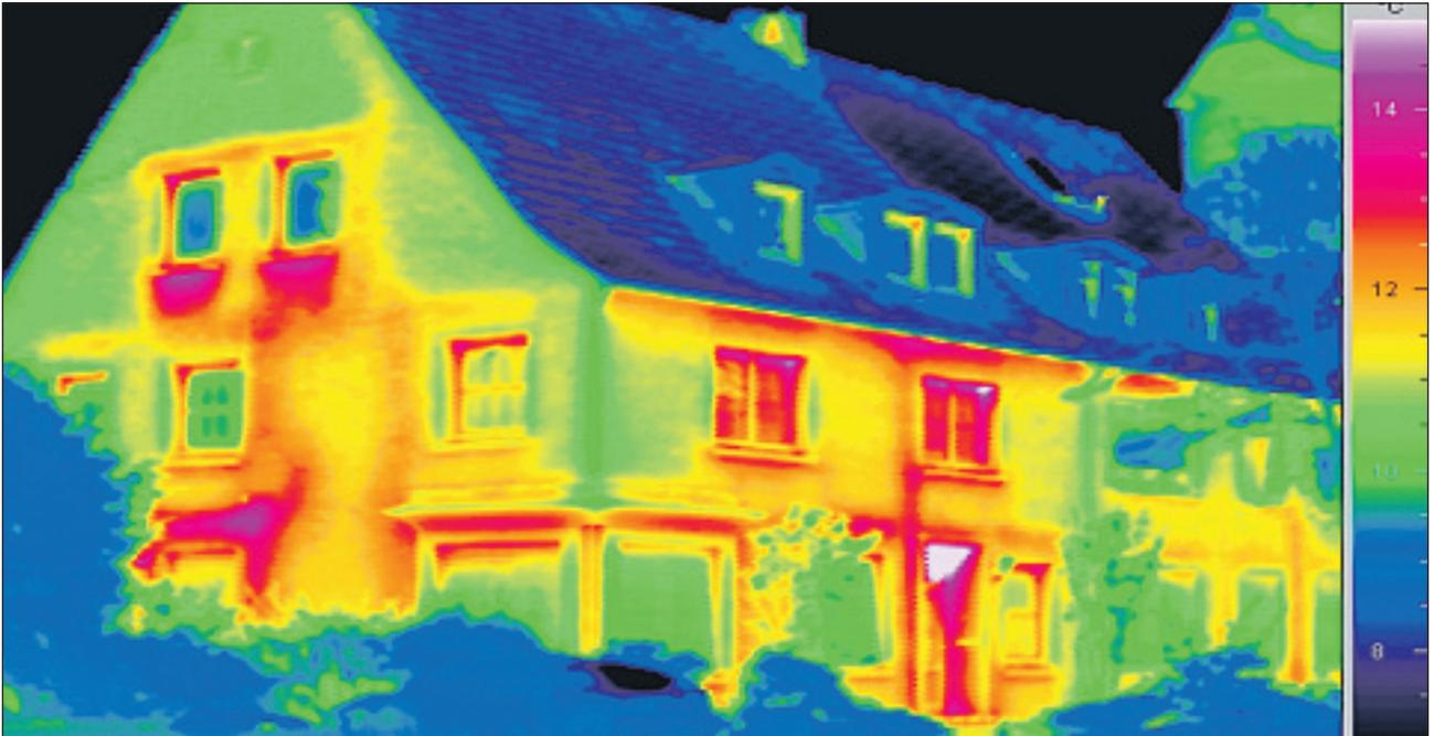
Wärmebild-Aufnahmen liefern konkrete Hinweise auf Wärme- und Kältebrücken und helfen die Problemzonen eines Gebäudes zu identifizieren. Für die Entwicklung konkreter Konzepte zur energetischen Gebäudesanierung sowie deren Umsetzung bedarf es des Einsatzes von qualifiziertem Fachpersonal. Bild: Verband Privater Bauherren (VPB)
