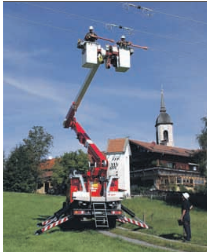
Arbeiten unter Spannung.
