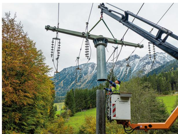
Die Netz-Experten haben den alten Mastkopf, die sogenannte Traverse, demontiert und eine neue Traverse auf den Mast gesetzt, von der künftig Leiterseile nur noch in eine Richtung abgehen werden. In der anderen Richtung wird das Erdkabel angeschlossen. Bild: LEW / Timian Hopf
