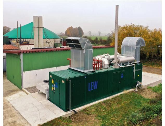
Der landwirtschaftliche Betrieb betreibt seit dem Jahr 2009 eine Biogasanlage, an die bereits drei Blockheizkraftwerke gekoppelt sind. Das neu installierte vierte BHKW nutzt das Unternehmen ausschließlich dazu, die Stromproduktion zeitlich zu flexibilisieren.
