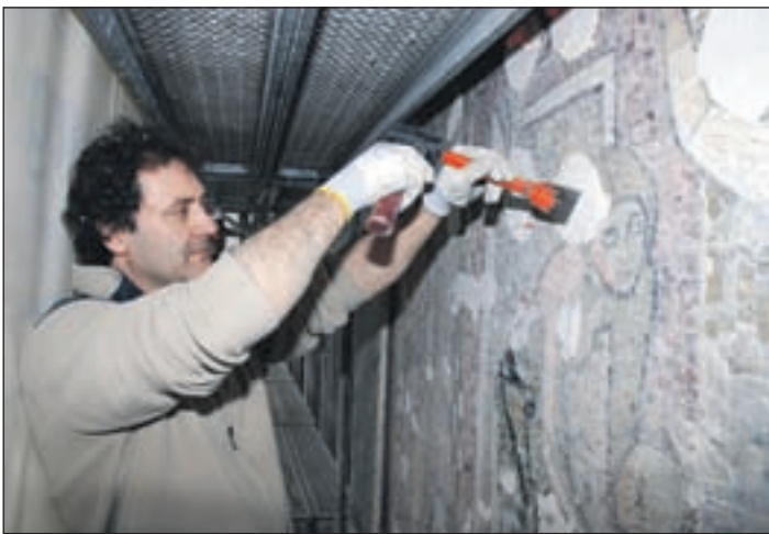
Der Mosaizist Valerio Lenarduzzi von der Mayer'schen Hofkunstanstalt sichert das Natursteinmosaik an der Fassade des Kreissparkassengebäudes am Martin-Luther-Platz. □
