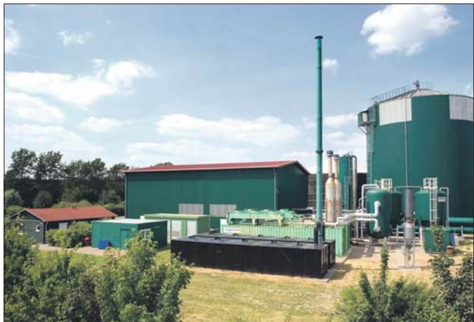
Moderne Technik für klimafreundliche Energie: In der Biogasanlage Karstädt erzeugt Evonik Strom für rund 2.000 Haushalte.
