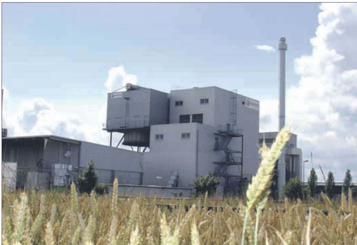
Das Biomasse-Kraftwerk liegt am östlichen Rand der 5.000-Einwohner-Gemeinde Großbaitingen.
