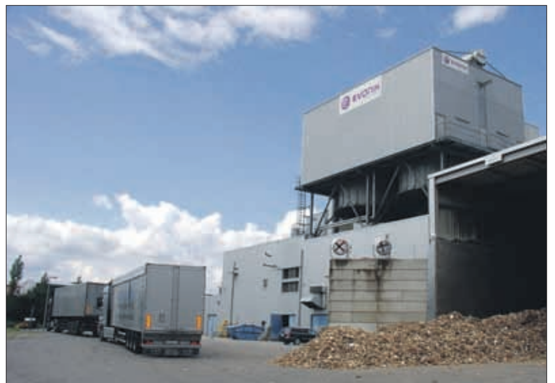
Zwei Holztransporter warten auf das Abwiegen im Innenhof des Kraftwerks. □
