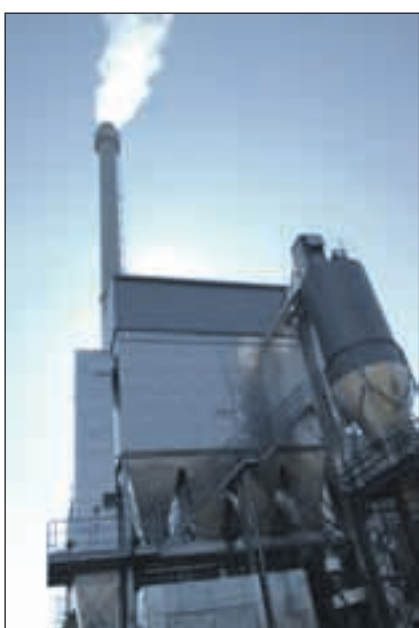
Die Rauchgasreinigungsanlage mit Kamin.
