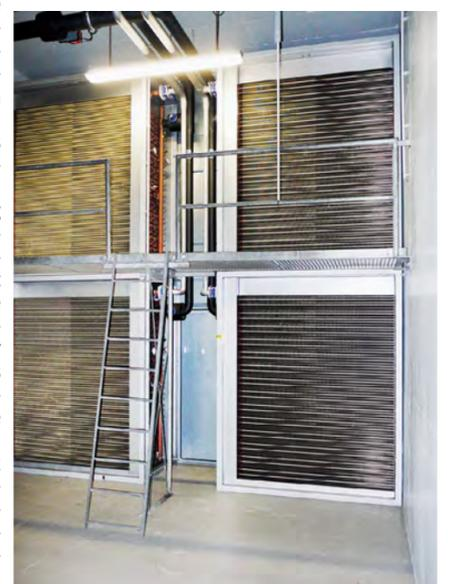
In Rohrrahmengestellen montierte GSWT-Wärmetauscher kommen zur freien Aufstellung im Ansaugbauwerk zum Einsatz. Bild: SEW GmbH, Kempfen
