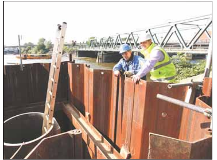
Dienstleistung im Rahmen der Gütesicherung Kanalbau: Stichprobenartige Kontrolle der Eigenüberwachung und Beratung durch den vom Güteausschuss beauftragten Prüflingenieur. Foto: Güteschutz Kanalbau
