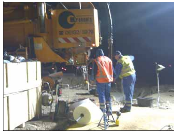
Für die Sanierung stand nur ein Zeitfenster von sechs Stunden in der Nacht zur Verfügung. So mussten die Bauabläufe bis auf die Minute genau eingehalten werden, um die Sanierung bis 5:00 Uhr erfolgreich abschließen und die Baustelle vor Flugbetriebsbeginn verlassen zu können.
