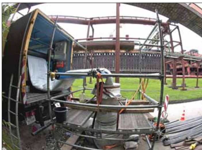
Schlauchlinersanierung auf Zeche Zollverein: Die Mischanlage ist im so genannten DS CityLiner untergebracht. Foto: D&S
