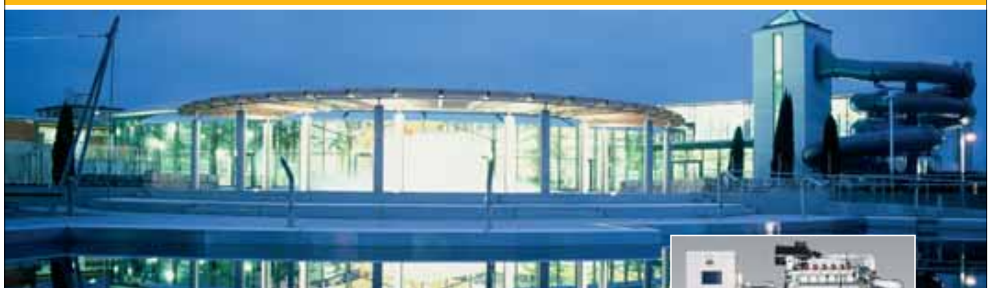
Ergomar Erlebnisbad in Ergolding – für Wärme und Strom sorgt ein Blockheizkraftwerk
